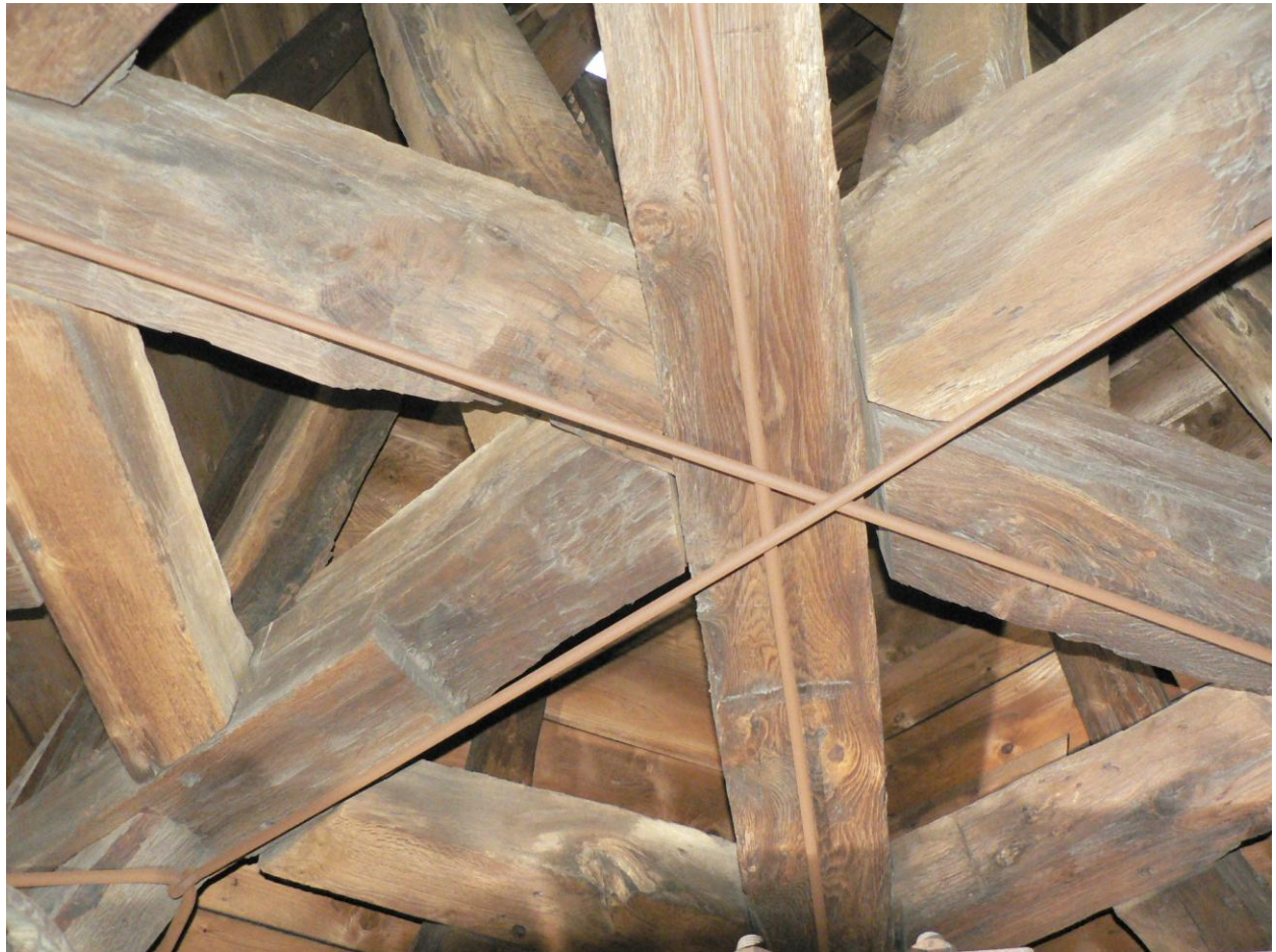
Blick von der Glockenstube aus auf das mächtige Grundgebälk des sechseckigen Turmhelms
