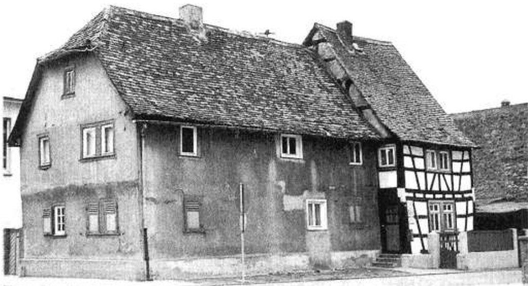
Das Melksche Haus an der Kirchstraße/Ecke Ernst-Ludwig-Straße, wurde abgerissen.
