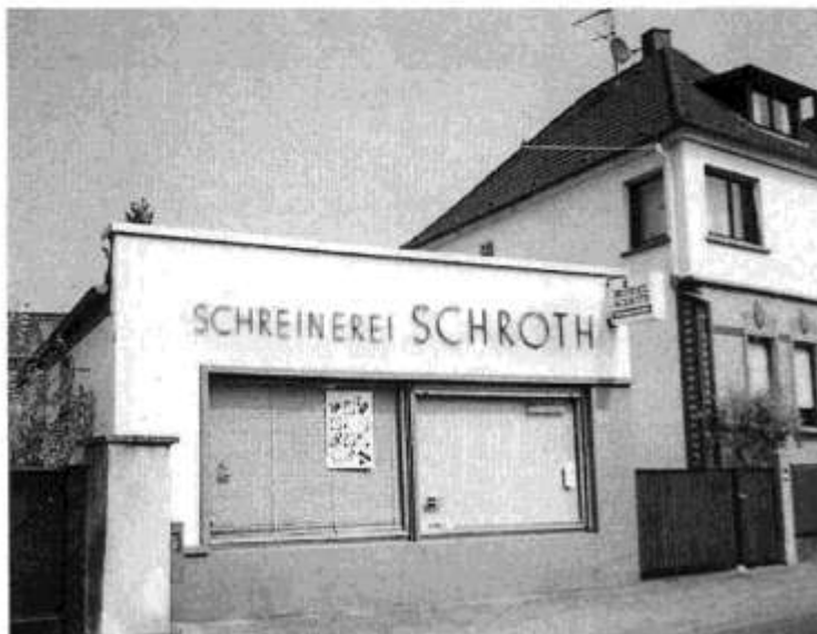
Vor dem Neubau der Werkstätte stand hier ein Haus mit einem Friseurgeschäft, Bahnstr. 86 (Andreas Schneider)
