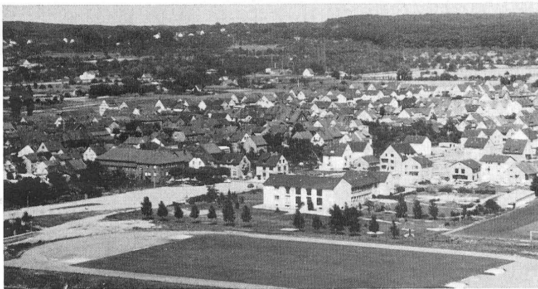
Sportplatzanlagen mit Bürgerhaus
