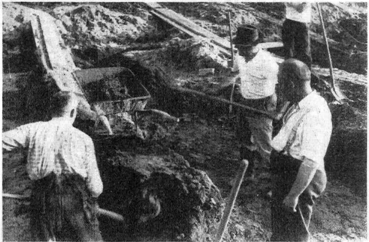
Egelsbacher Ortsbürger bei Ausschachtungsarbeiten
